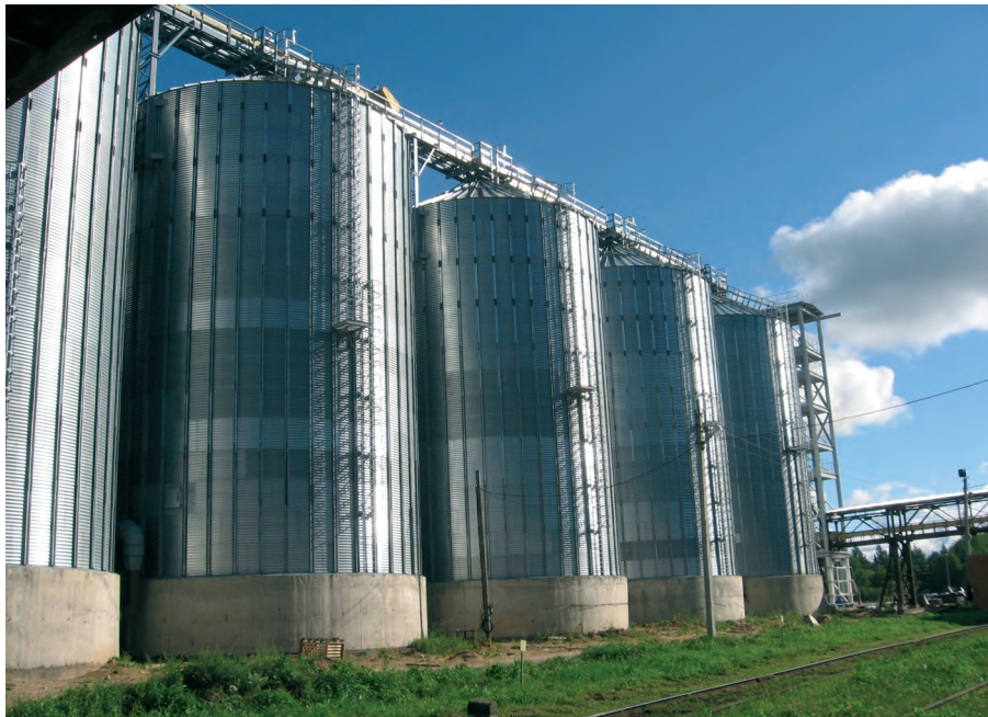
Рис. 1. Силосный корпус элеватора
