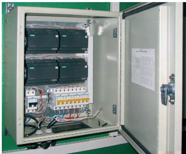
Рис. 7. Монтаж блока БП-240
