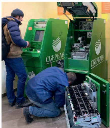
Рис. 2. Иллюстрация регламентных работ в открытой зоне
