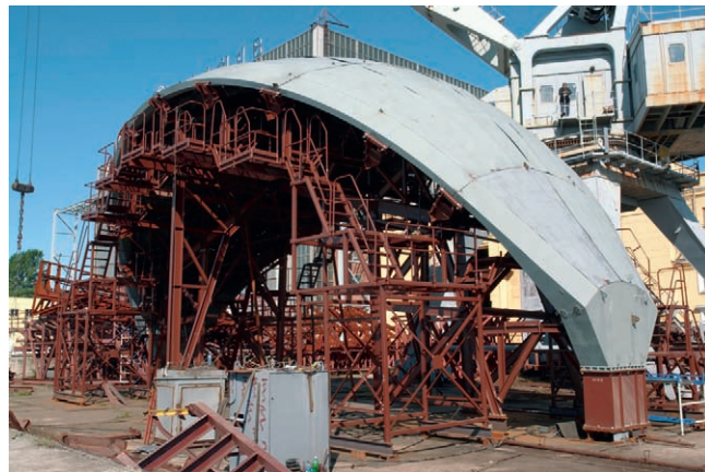
Рис. 5. Одна из створок на заводском стапеле
