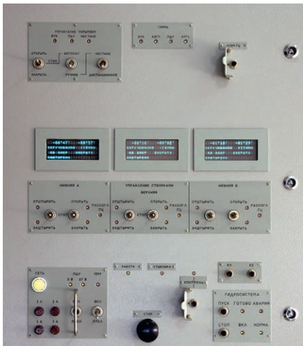
Рис. 8. Пульт дистанционного управления укрытием
