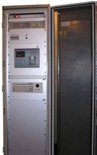
Рис. 4. Внешний вид шкафа САУ блюминга
