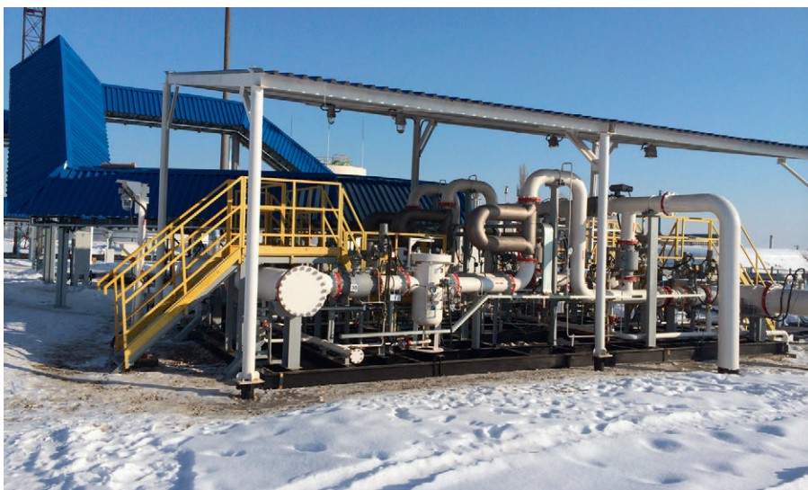
Рис. 1. Узел коммерческого учёта нефти
