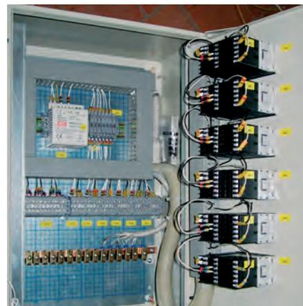
Рис. 4. Внешний вид шкафа управления системы автоматизации БСУ НПФ «Ракурс»
