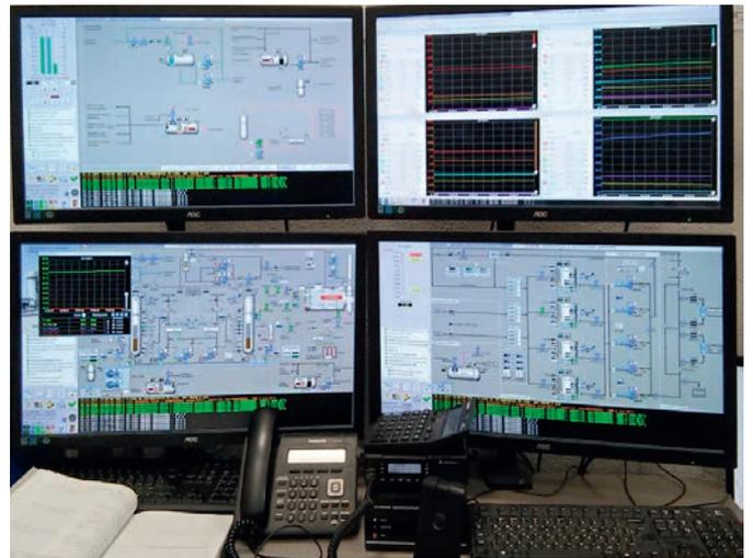
Рис. 5. Автоматизированное рабочее место оператора комплекса производства битума
