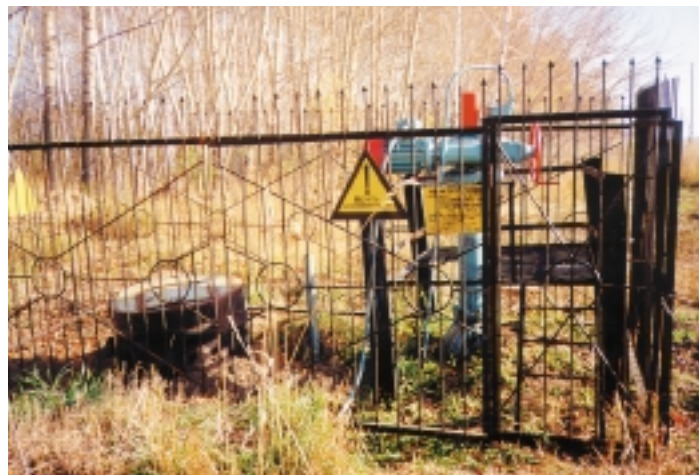
На трассе нефтепровода
