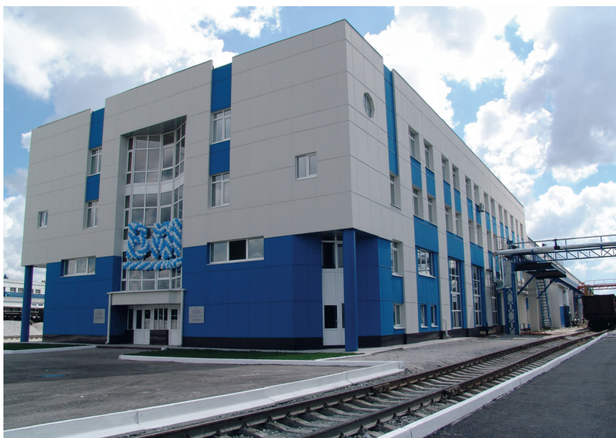
Рис. 1. Здание депо Свердловск-Сортировочный, где находятся вагонно-колёсные мастерские
