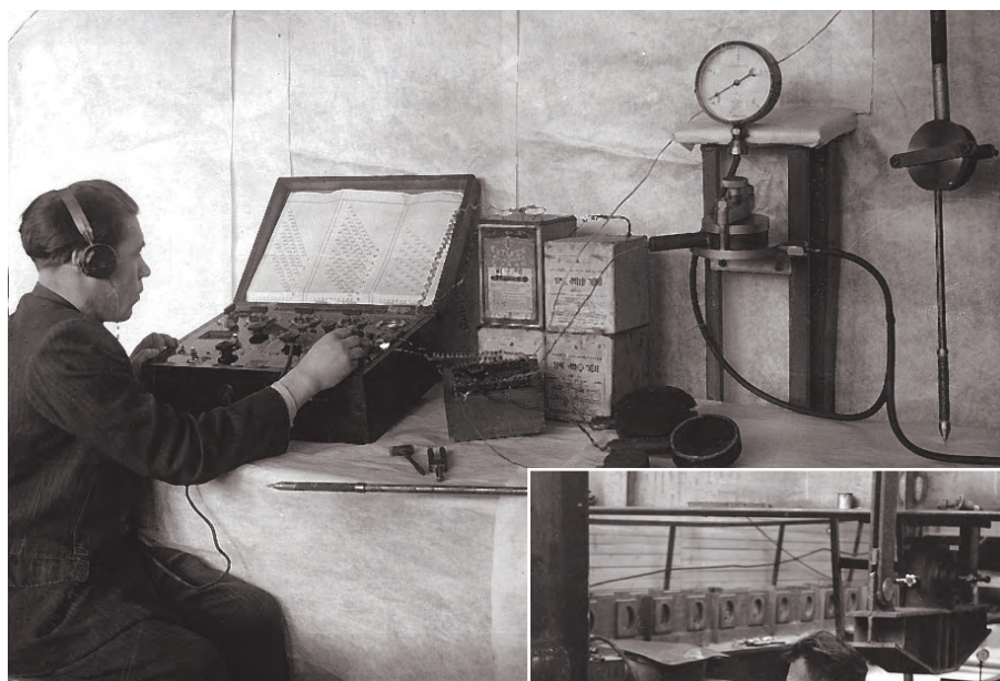
Рис. 20. Исторические фото: инженер ВНИИГ, рационализатор и изобретатель СССР П.Н. Кашкаров при контроле параметров оснований грунтов Братской ГЭС
