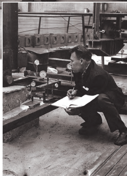
Рис. 20. Исторические фото: инженер ВНИИГ, рационализатор и изобретатель СССР П.Н. Кашкаров при контроле параметров оснований грунтов Братской ГЭС
