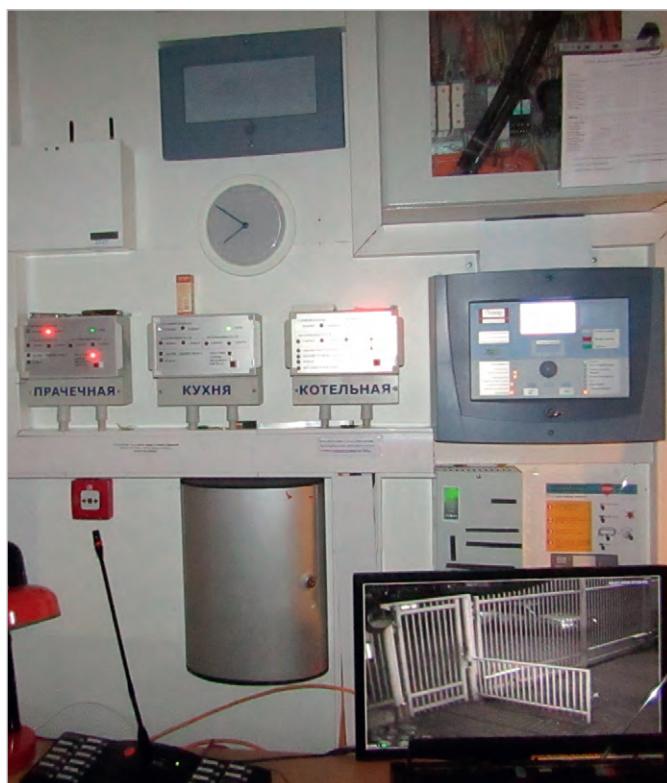
Рис. 5. Интегрированная система пожарного оповещения
