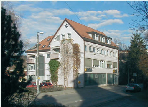
Здание главного офиса компании Pepperl+Fuchs EXTEC GmbH
