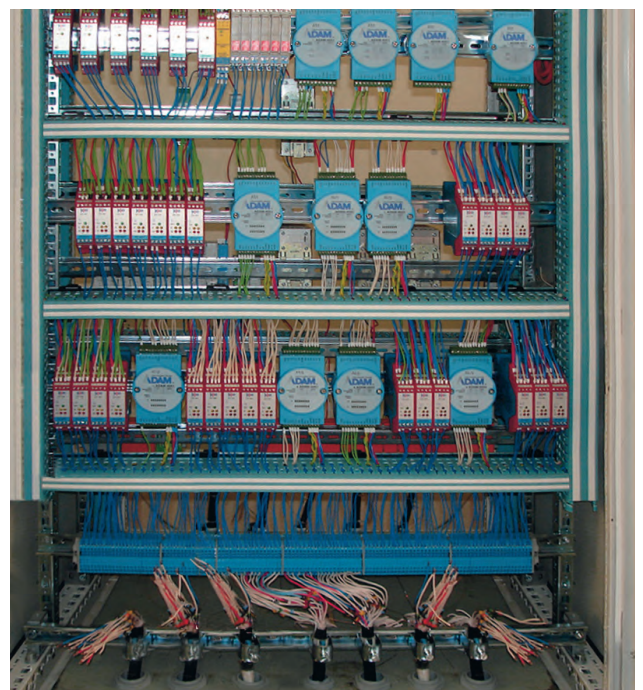
Рис. 4. Шкаф УСО (M256), сконструированный с помощью программы BOX 2004
