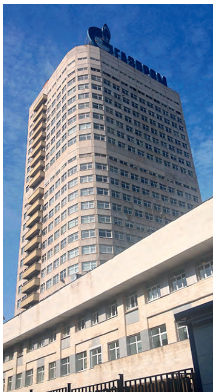
Рис. 1. Бизнес-центр «Газпром Энергодом»
