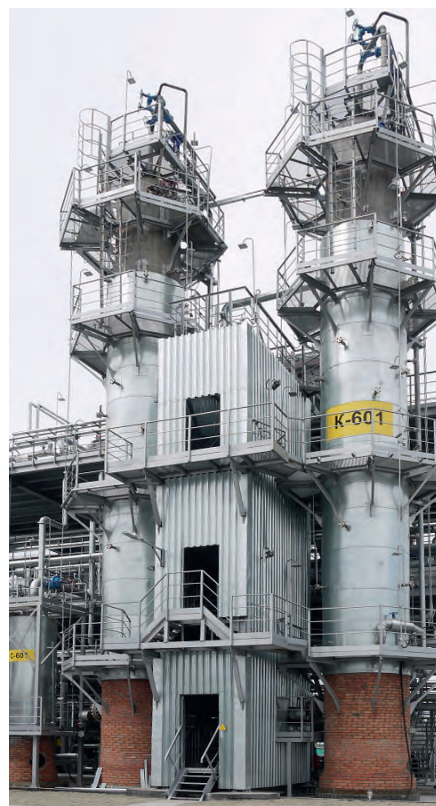
Рис. 2. Колонны окисления гудрона
