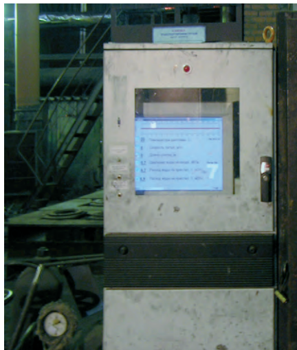
Рис. 5. Шкаф с промышленным компьютером PPC-174Т (АРМ плавильщика)
