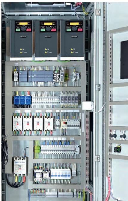
Рис. 1. Компоновка шкафа с ПЧ
