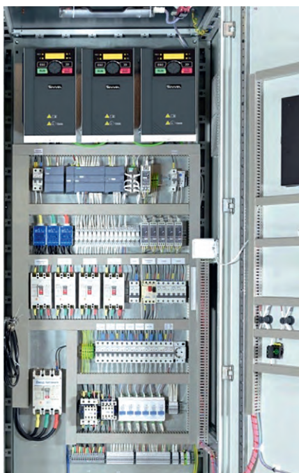
Рис. 1. Компоновка шкафа с ПЧ
