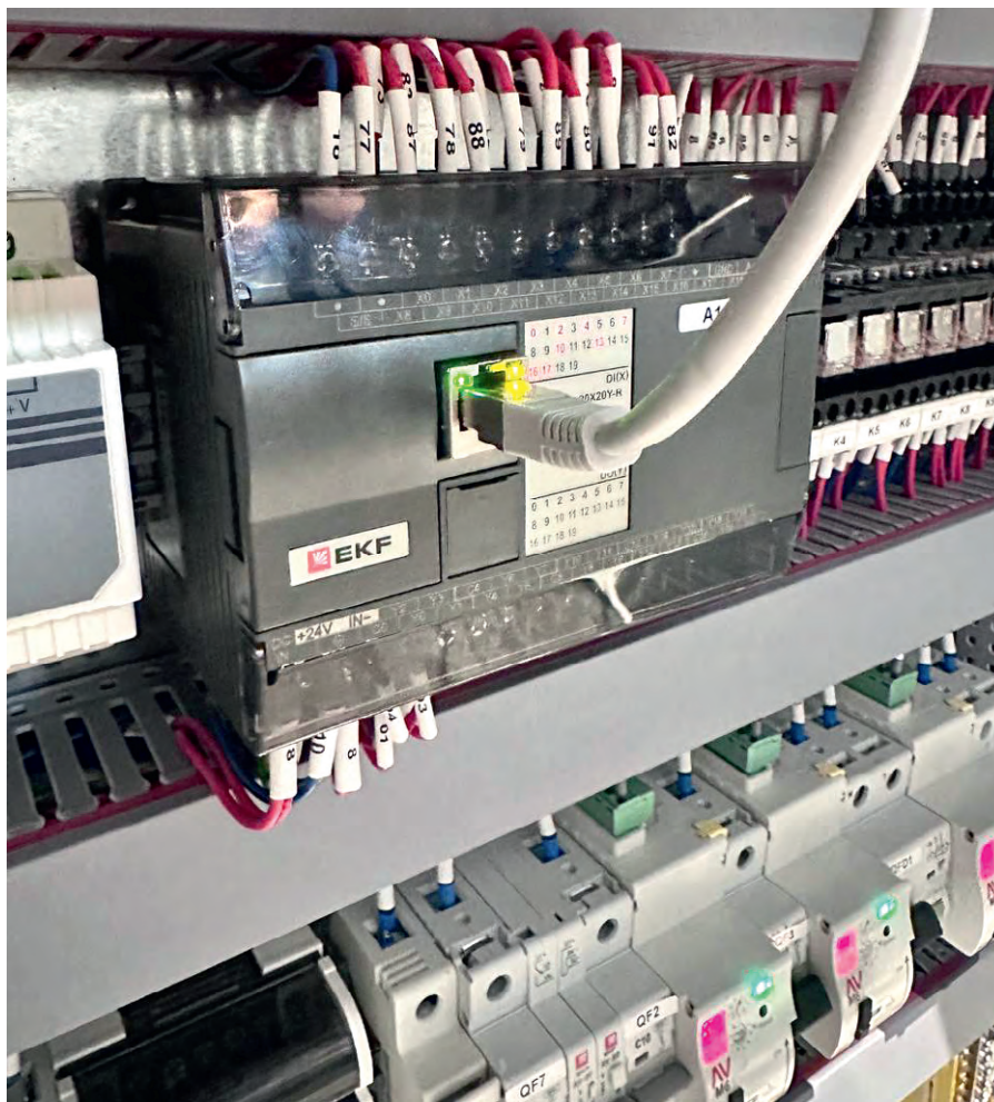
Рис. 2. Система мониторинга инженерных систем в порту, г. Мурманск
