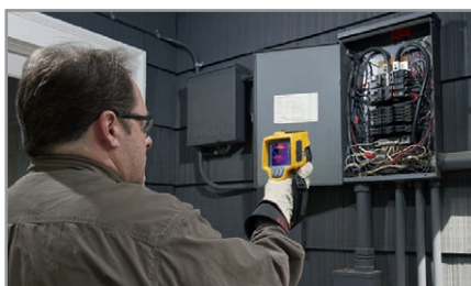
Рис. 17. Контроль распределительных щитов
