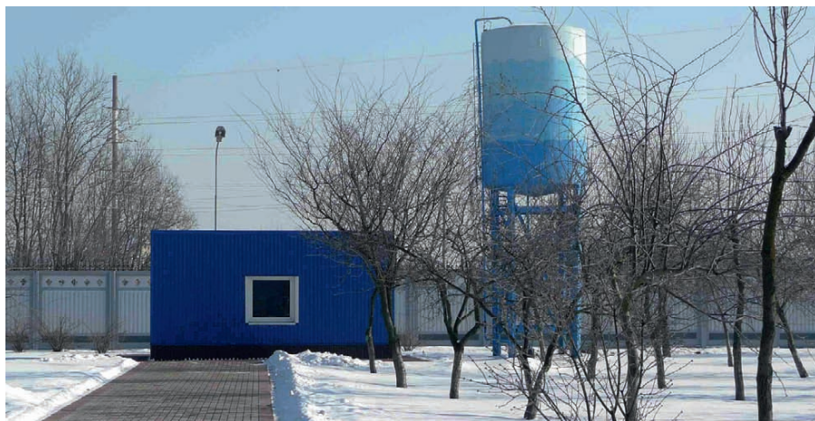
Рис. 3. Скважина (ВНС первого подъёма)
