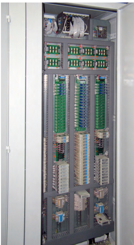
Рис. 4. Монтаж аппаратных средств АСУ
