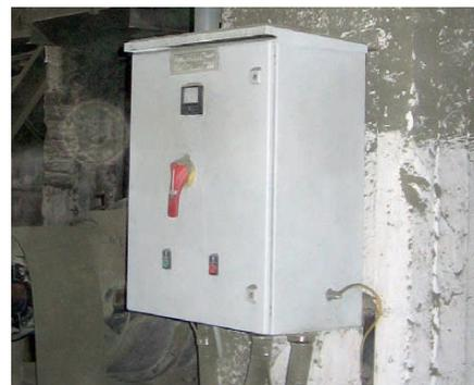
Рис. 9. Местный выключатель безопасности
