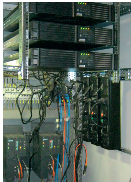
Рис. 9. Резервированный контроллер S7-400 в шкафу ПЛК АСУ «Ротор» БМЗ (Индия)
