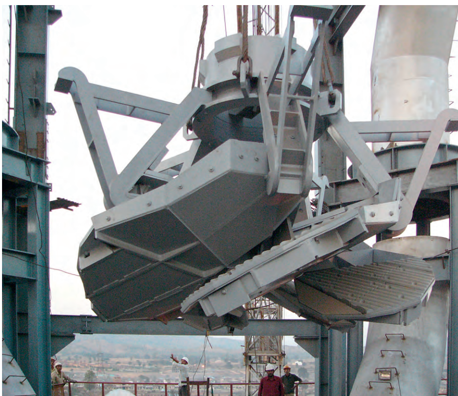
Рис. 1. Роторный распределитель как основная часть РЗУ
