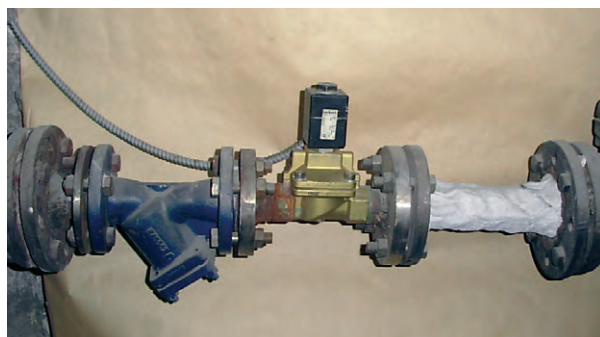
Рис. 3. Электромагнитный клапан подачи пара в камеру
