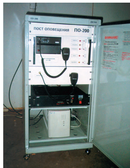
Рис. 2. Системный блок поста оповещения с открытой дверцей
