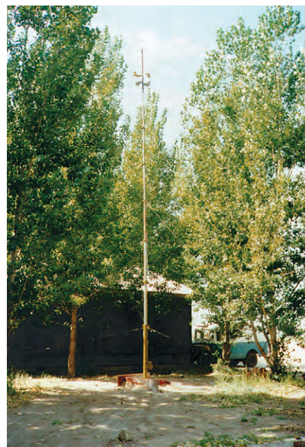
Рис. 3. Мачта поста оповещения с антенно-фидерным устройством и комплектом громкоговорителей и сирен
