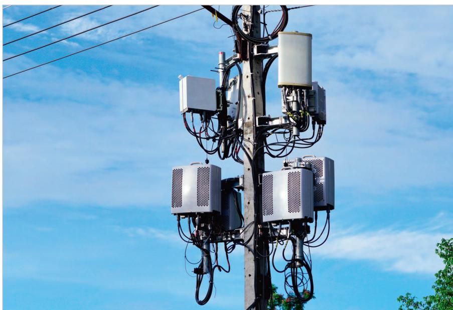
Рис. 1. Пример базовой станции 5G-диапазона FR2
