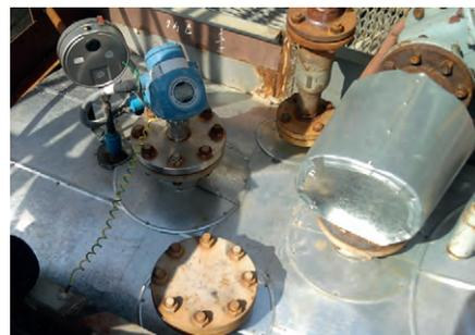
**Рис. 1. Rosemount 5300 смонтирован на выпарном аппарате установки сероочистки в успокоительной трубе вместо буйкового уровнемера**
