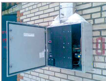
Рис. 14. Генератор ТЭГ-15 на газораспределительном пункте
