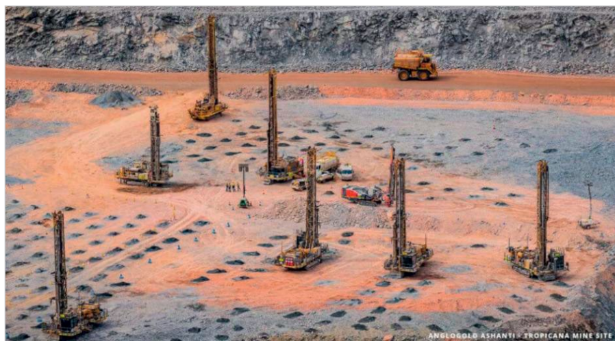
Рис. 2. Бурение шурфов компанией Flanders с коррекцией координат по сигналам ГНСС
