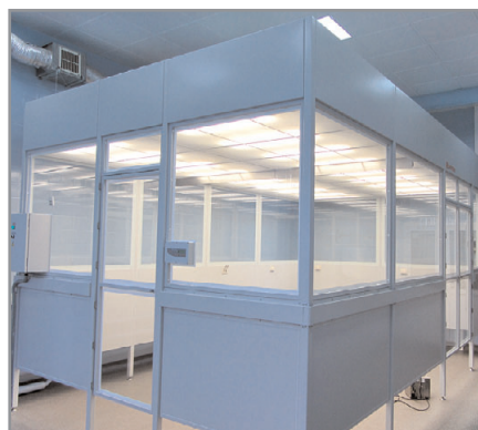
Рис. 3. Размеры рабочей зоны комплекса 5000 × 3000 × 2400 мм
