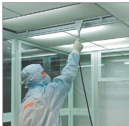
Рис. 4. Аттестация чистой зоны после монтажа
