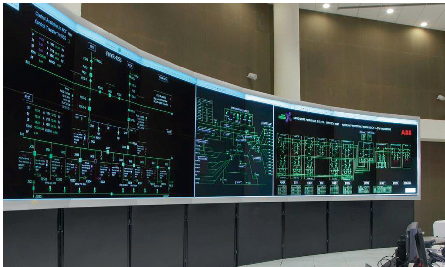
Рис. 3. Видео стена на основе видеокубов Delta
