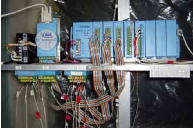
Рис. 3. Контроллер ADAM-5000E со встроенными модулями, источником питания PWR-243 и преобразователем интерфейса ADAM-4520
