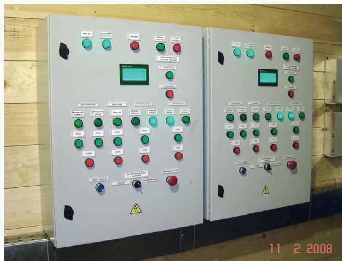
Рис. 1. Внешний вид шкафа автоматики ША-ЛСК-04
