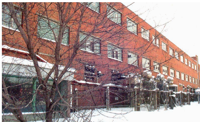
Чепецкий механический завод: здание отделения по производству порошка циркония
