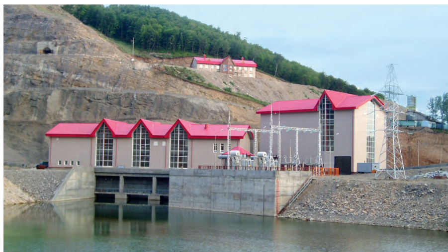
Рис. 1. Общий вид Юмагузинской ГЭС
