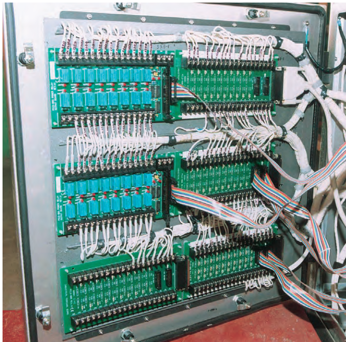
Рис. 2. Подключение сигналов через клеммные платы
