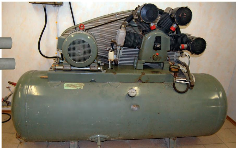
Рис. 5. W-образный компрессор пневмолинии с ресивером
