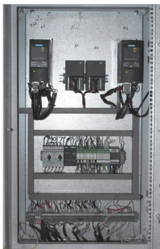
Рис. 3. Шкаф управления электроприводом
