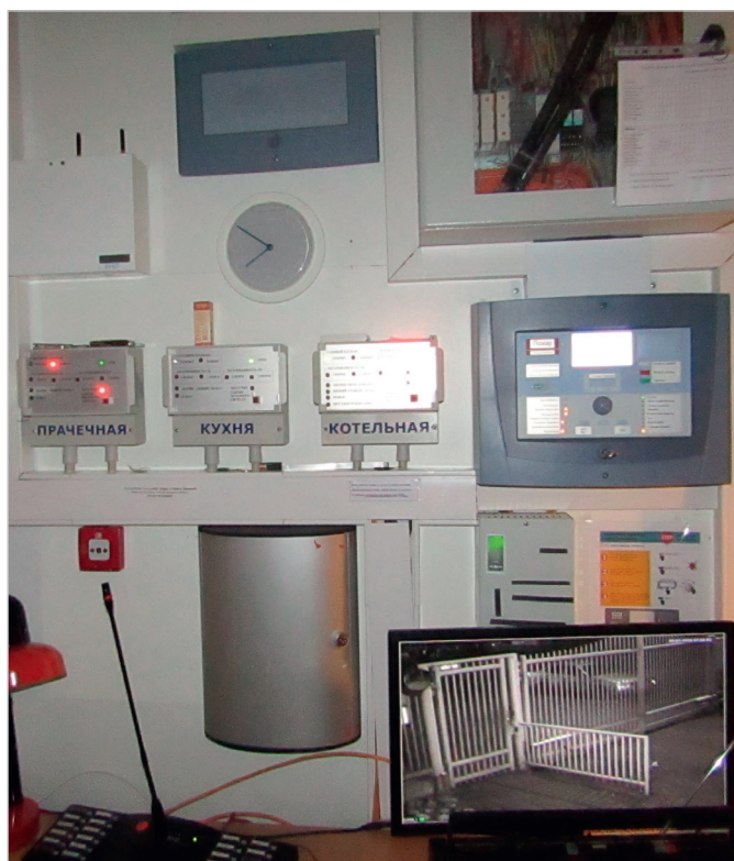
Рис. 5. Интегрированная система пожарного оповещения
