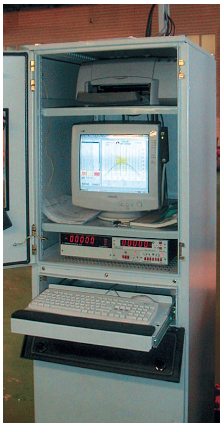
Рис. 3. Шкаф управления стенда тестирования ЭЦН
