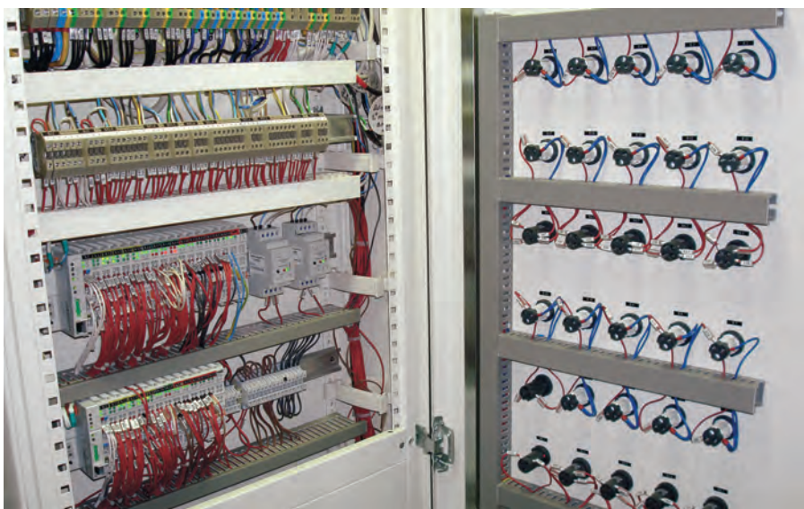
Рис. 7. Внешний вид шкафа локальной автоматики системы вентиляции
