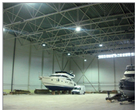
Энергосберегающее освещение индукционными лампами эллинг в С-Петербурге (порт Дубровка)
