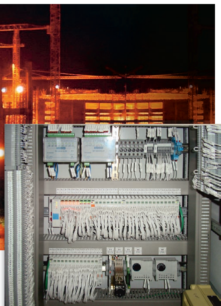
Рис. 9. АЭС «Куданкулам» (Индия) и контроллер FASTWEL I/O CPM703 в составе оборудования одной из систем контроля и управления установки отверждения жидких радиоактивных отходов
