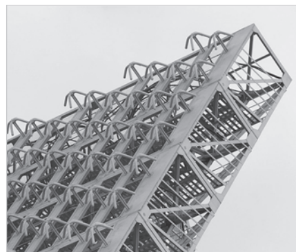
Рис. 14. Участок фазированной решётки антенны РЛС «Воронеж-М»
