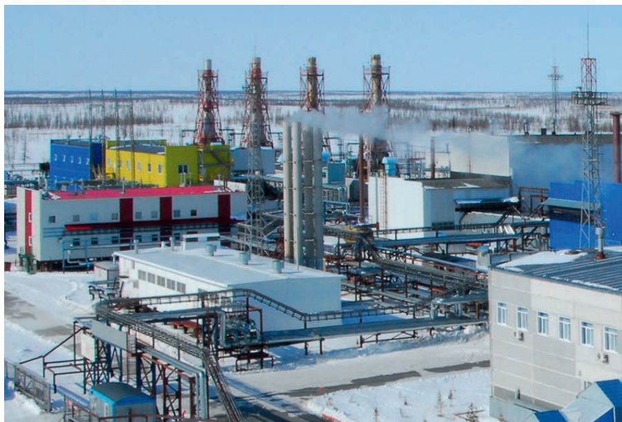
Рис. 1. Газотурбинная электростанция собственных нужд
