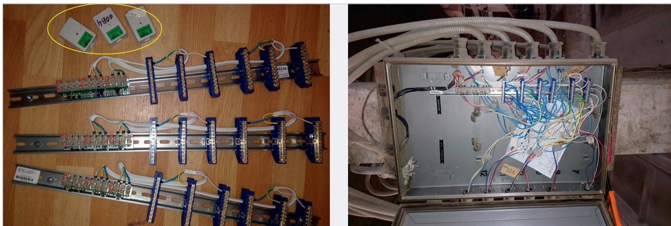
Рис. 4. Фото монтажа МСВ на DIN-рейку (слева) и смонтированная МСВ в шкафу термометрии (справа)
