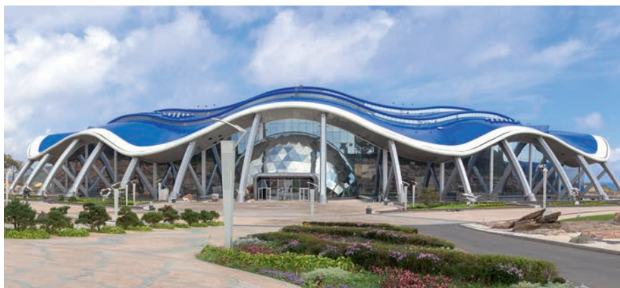
Рис. 1. Главный корпус Приморского океанариума
