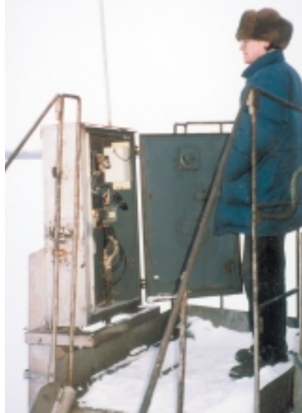
Установка контроллера «Мега-СКВ» и антенны на площадке монтажа электрооборудования скважины
