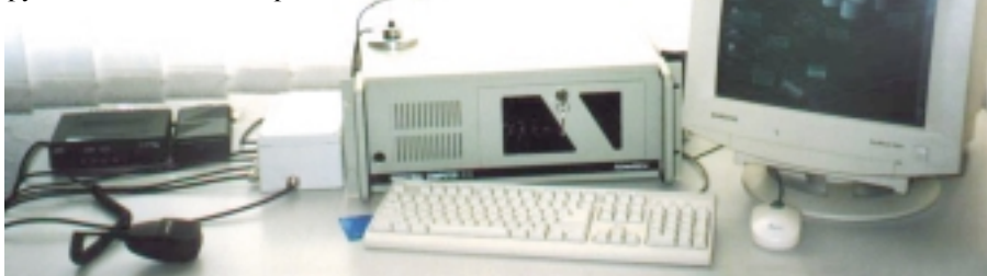
Рис. 3. Оборудование диспетчерского пункта
