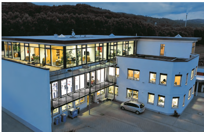
Рис. 3. Здание, в котором находятся головной офис, лаборатории и производственные площадки компании Thermokon
