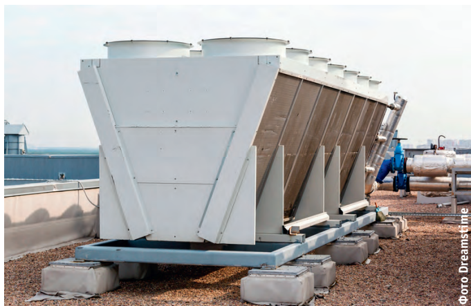
Рис. 1. Аппарат воздушного охлаждения
