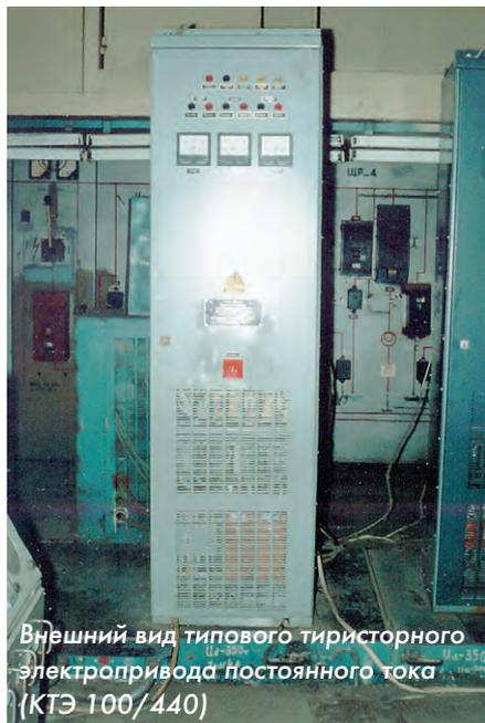
Внешний вид типового тиристорного электропривода постоянного тока (КТЭ 100/440)
