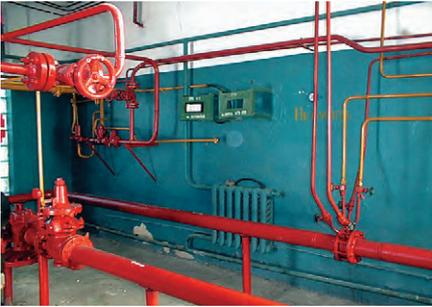
**Рис. 1.** Оборудование ГРП: трубки-отводы для датчиков
