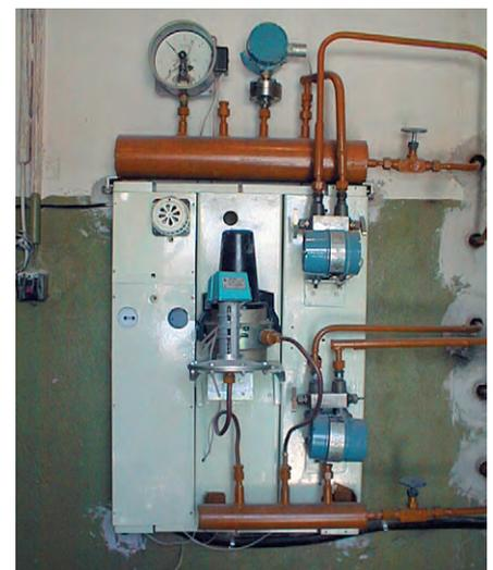
**Рис. 3. Вариант исполнения щита измерительных и сигнализирующих приборов и датчиков**
