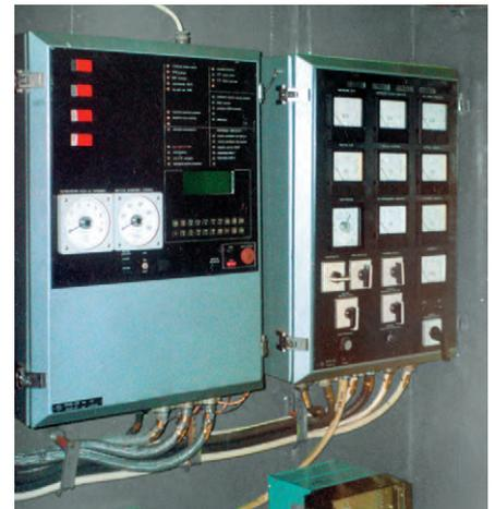
Рис. 5. ПУД и ПУГ в блоке управления электростанции
