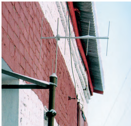
Рис. 6. Антенна, используемая для передачи данных по радиоканалу
